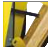
Sangles renforçant le maintien de la façade
